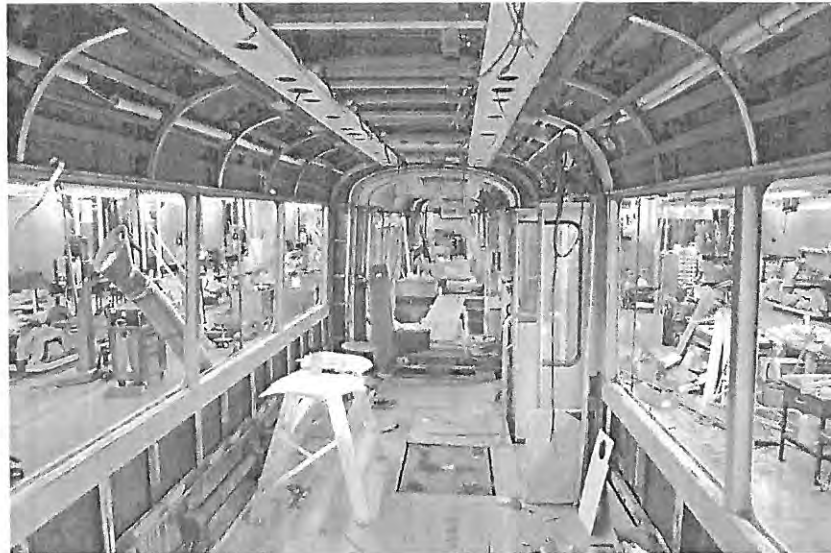
Kuva 1 Sisäkaton rakentamista ja rungon kunnostusta. Sisäkaton rakentaminen oli ennakoitua vaativampi projekti.
